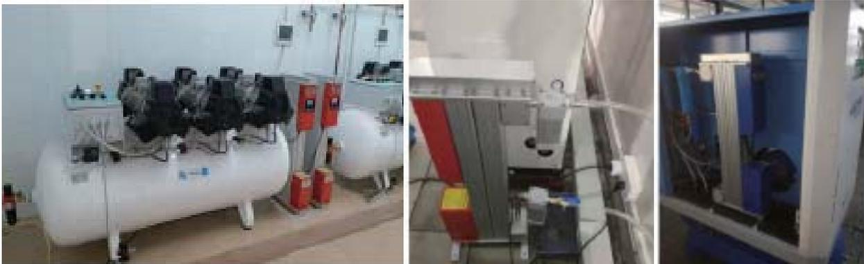
对于任何设备，如果在生产厂家进行维修都比较简单，如果在安装现场，由于人员的技术熟练水平、空间和工具等的局限性，进行维修比较困难。特别是如果现场装填干燥剂不当，会造成干燥剂快速粉末化，堵塞消音器，造成能量浪费，甚至造成下游空气污染和设备堵塞。在工厂预先生产好的干燥滤芯，可以在现场很方便的更换，一个人大概半个小时之内会完成整台干燥器干燥滤芯的更换工作。
